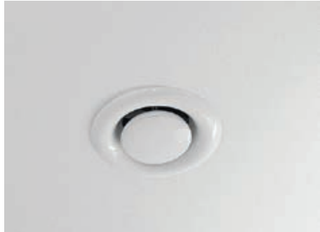
Стандартный клапан активной вентиляции в кухне и санузлах
