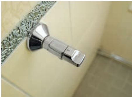
Подключение стиральных машин (для отделки «под ключ»)
