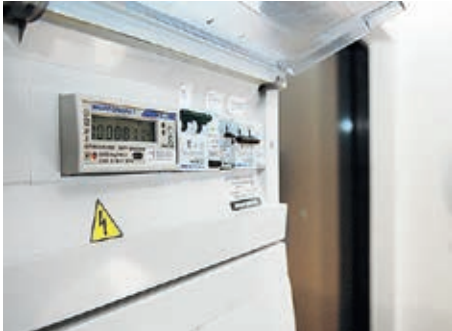
Двухтарифные счетчики и устройства защитного отключения
