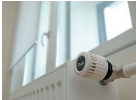
Стальные панельные радиаторы с терморегуляторами
